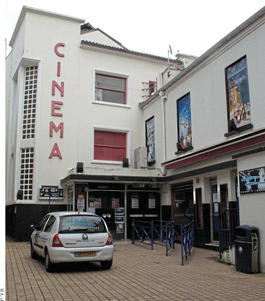
Rambouillet. Construit dans les années 1930, le cinéma d'art et d'essai devrait être démolé. Le permis de construire est en cours d'instruction.
